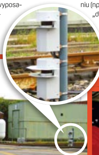
Rys. 2. Czujka umieszczona poziomo wykrywa obiekty znajdujące się na torowisku i wysyła sygnały do systemu CCTV i sterowania ruchem.
