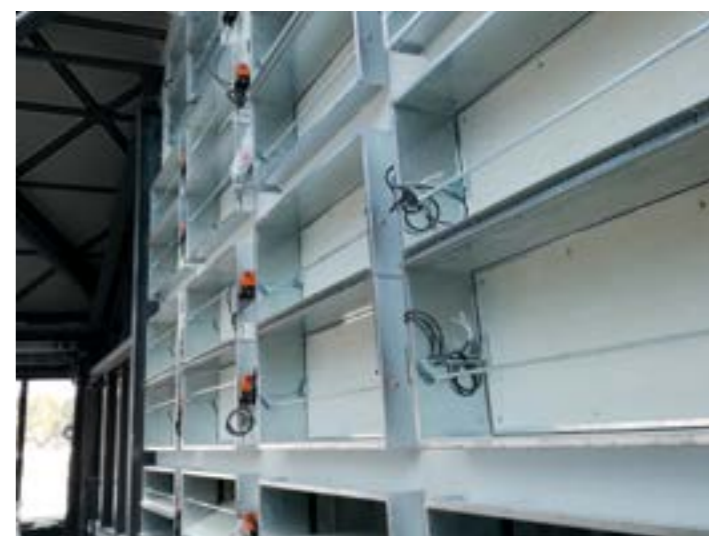
Fot. 2. Widok zespołu klapy odcinających zamykających wlot do oddymiających wentylatorów wyciągowych.
